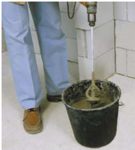
Der YTONG Planblockmörtel wird mit einem Quirl im Kübel angerührt.
